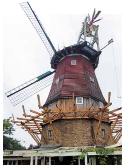
Die Arbeiten an der Galerie haben begonnen. Foto: © pro-t-in GmbH
